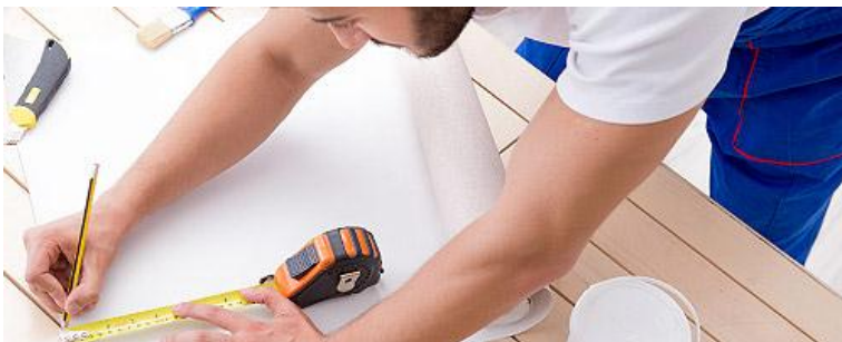
Строительные работы и ремонт помещений
